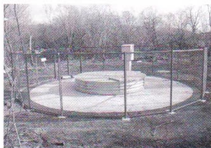
「第二水源設備」
